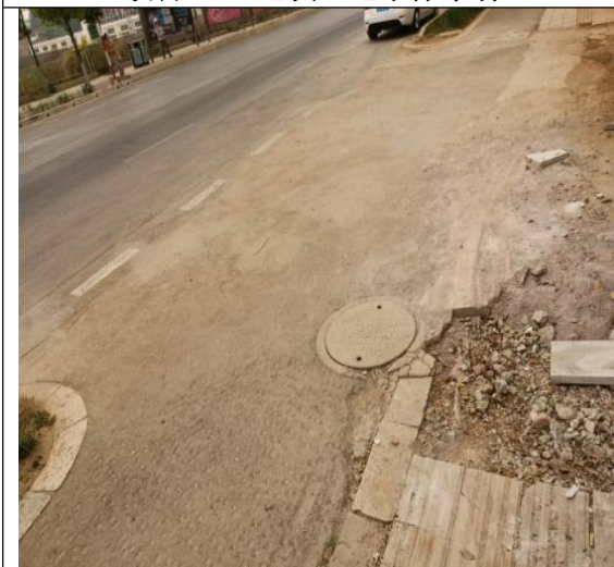
项目（A1 地块）废水总排口
