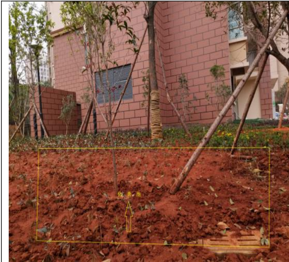
项目（A1 地块）地埋式化粪池
