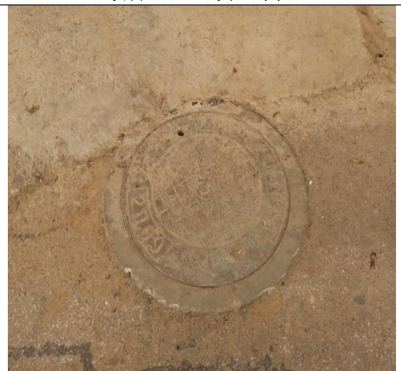
项目（A1 地块）雨水排放口
